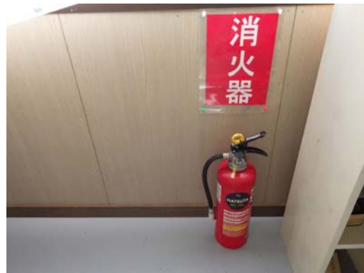
消火器の設置状況
