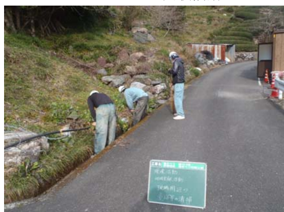
工事現場での清掃状況
